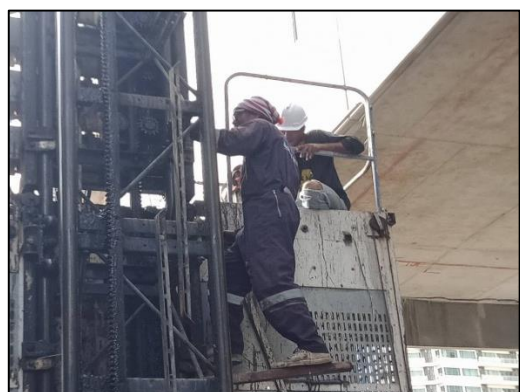
ภาพที่ 12 กิจกรรมใช้น้ำมันหล่อลื่นเครื่องจักร
